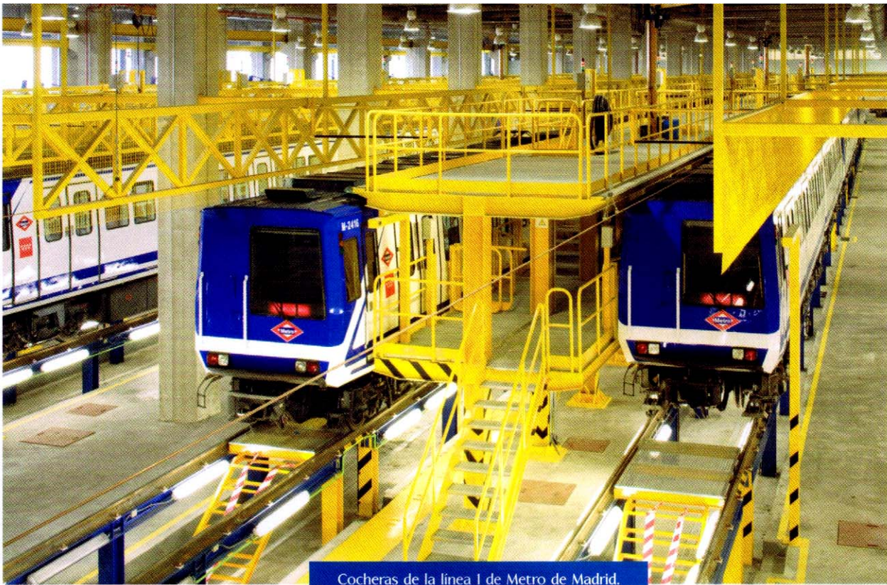
Cocheras de la línea 1 de Metro de Madrid. Abajo estación de Miraflores, línea de cercanías de Zaragoza.
